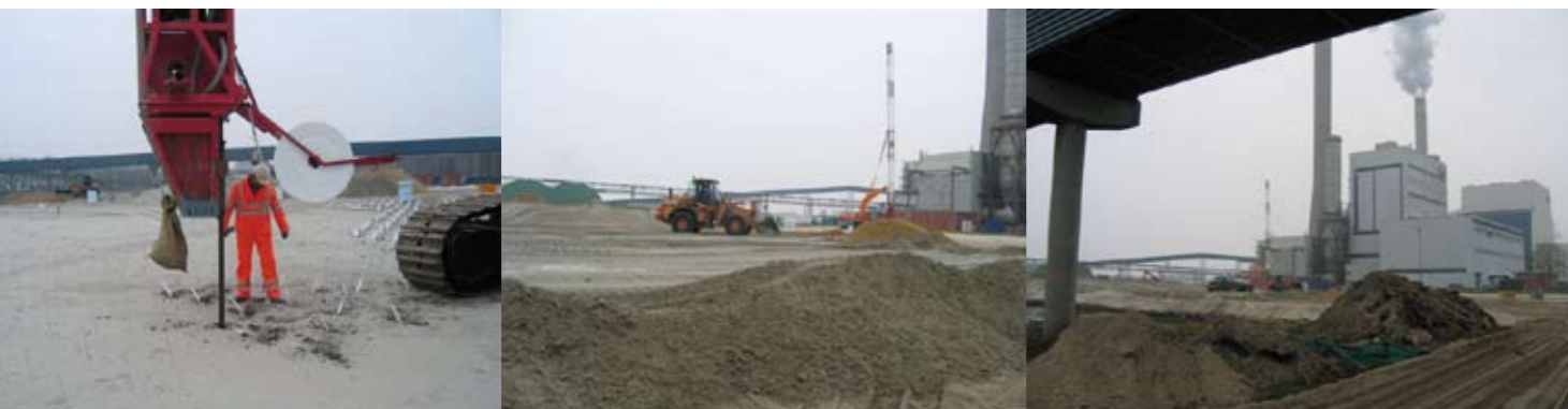
Bij de Hemwegcentrale in Amsterdam werd verticale drainage toegepast.
