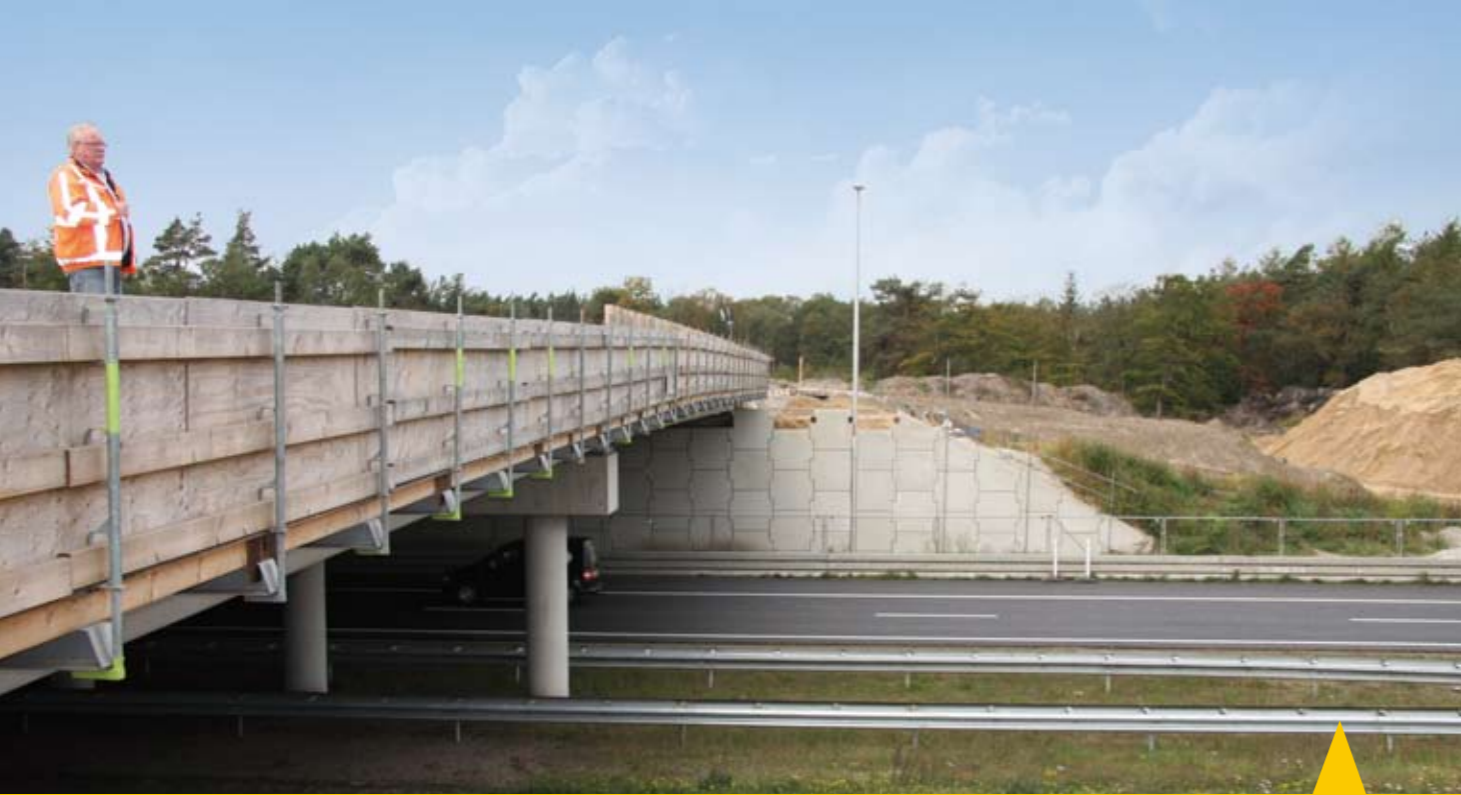
Henk Hogenkamp is uitvoerder op het werk dat onder andere bestaat uit het plaatsen van de Terre Armee-wanden.
